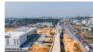
Dự án xây dựng cầu vượt trước bến xe miền Đông mới trên đường Xa lộ Hà Nội, Quận 9
