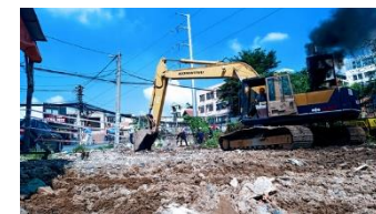
Xây dựng cầu Hang Ngoài, Gò Vấp
