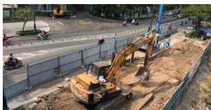
Nâng cấp đường Hương Lộ 11, Bình chánh
