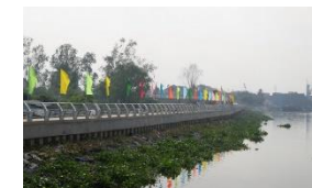
Xây dựng kè chống sạt lở Sông Sài Gòn, Bình Thạnh
