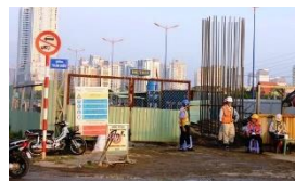
Xây dựng cầu Cây Đa, Củ Chi
