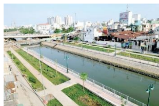
Dự án đường và kênh Nước Đen, Bình Tân
