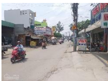
Nâng cấp đường Trần Văn Mừi, Hóc Môn
